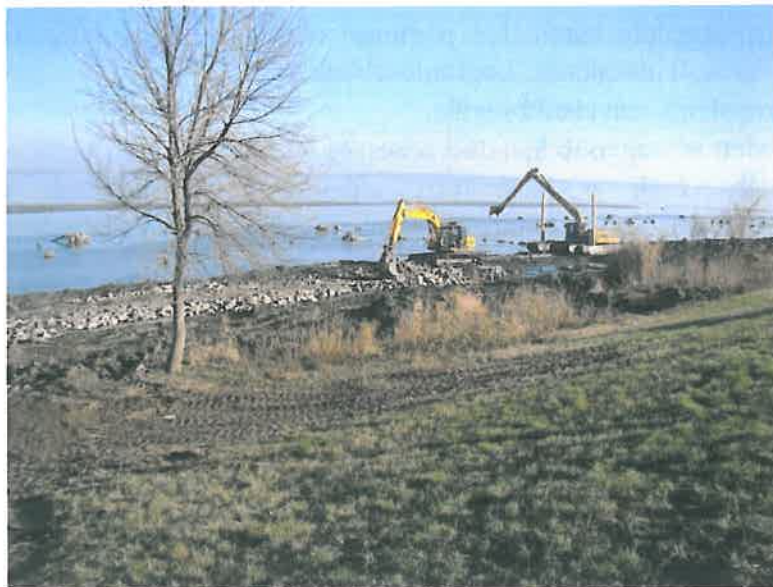
Hullámverés elleni védmű építése
