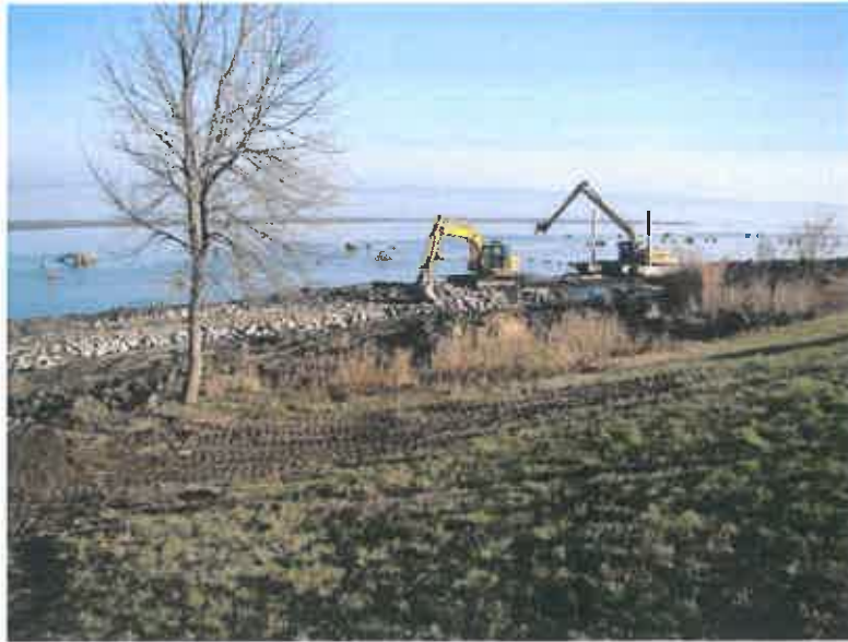
Hullámverés elleni védmű építése
