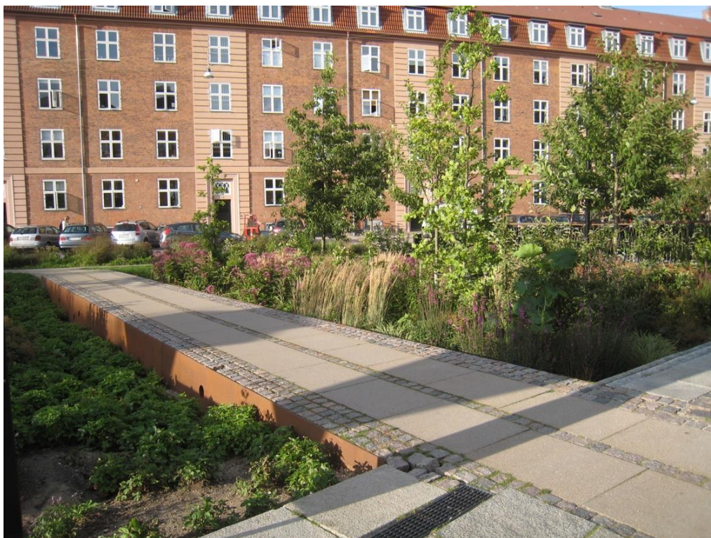
Vízáteresztő burkolat (fotó: Csizmadia Dóra)
