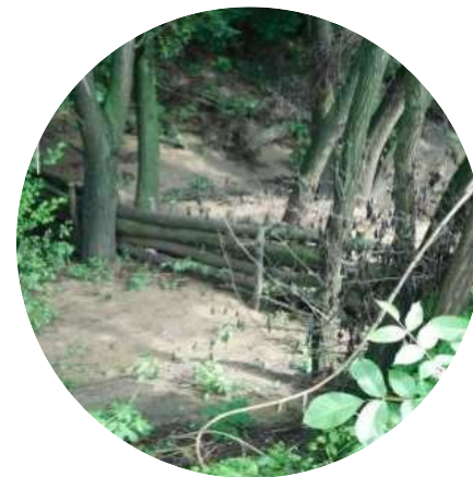
Püspökszilágy oldaltározó, rönkgátak, terméskőgátak felújítása, jó karban tétele
