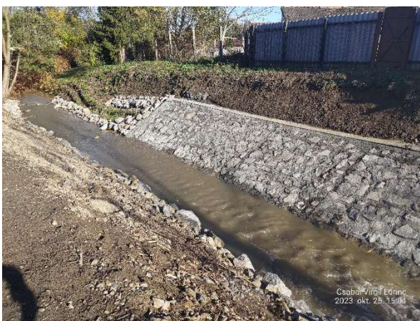
Parád, Recski-Tarna 14+030-14+070 szelvények közötti mederburkolat helyreállítása
