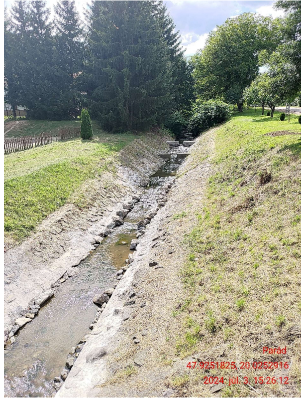
Parád, Recski-Tarna 15+630-15+730 szelvények közötti mederburkolat helyreállítása
