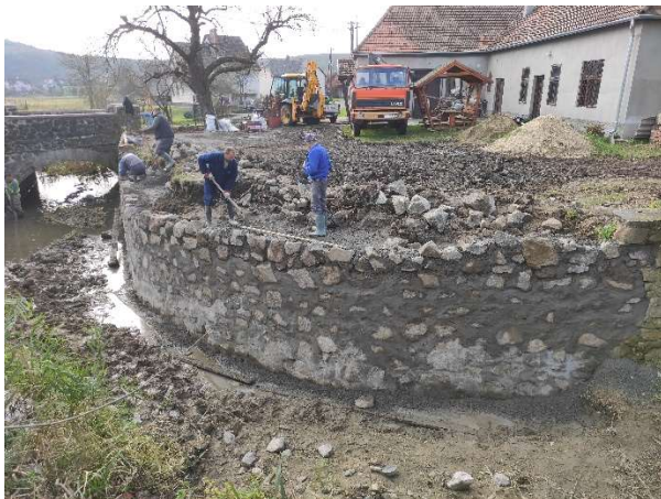
Bátor, Aranyos-patak partfal helyreállítás
