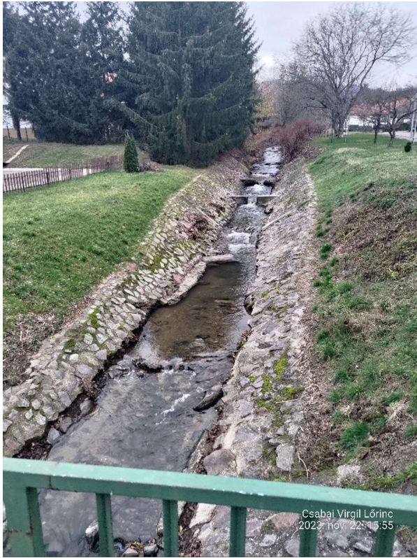
Parád, Recski-Tarna 15+630-15+730 szelvények közötti mederburkolat helyreállítása
