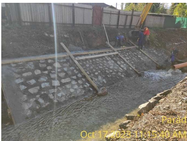
Parád, Recski-Tarna 14+030-14+070 szelvények közötti mederburkolat helyreállítása
