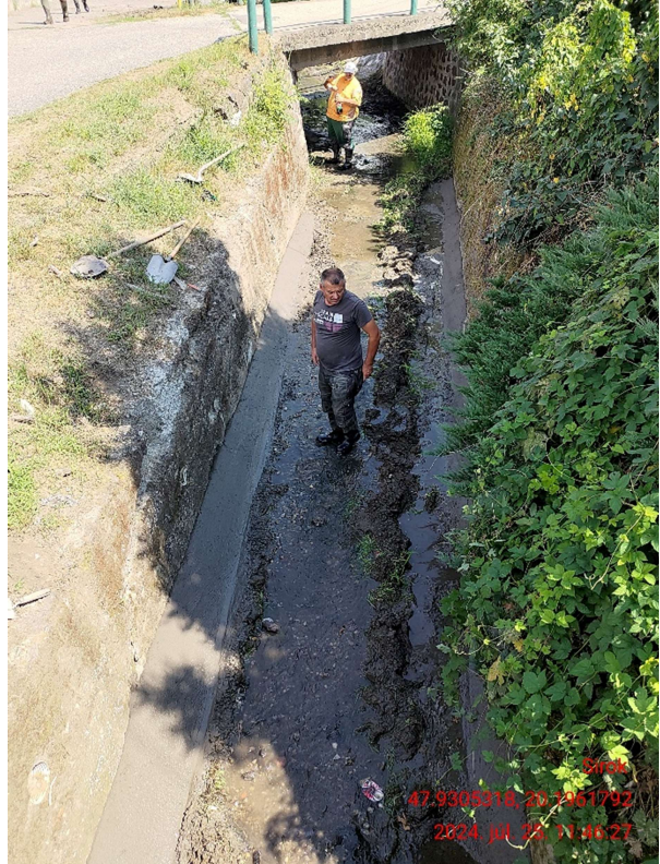
Sirok, Szabás-patak hordalék mederburkolat helyreállítása
