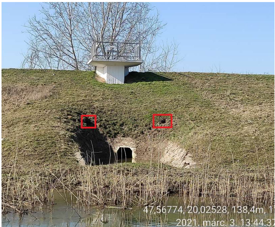
Hódyukak és hódjárat az árvízvédelmi töltés vízoldalán
