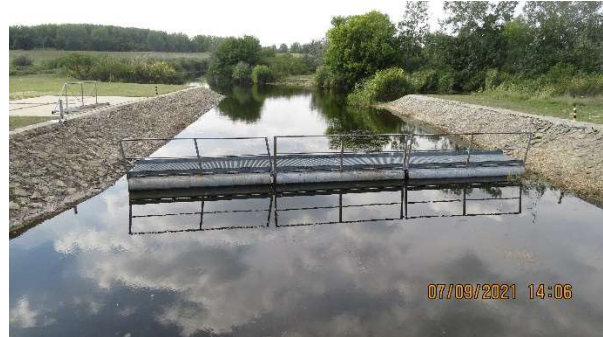
Újlőrincfalvai szivattyútelep a mozgógerebekkel és az uszadékkiszedő hídral
