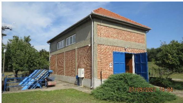
Újlőrincfalvai szivattyútelep a mozgógerebekkel és az uszadékkiszedő hídral
