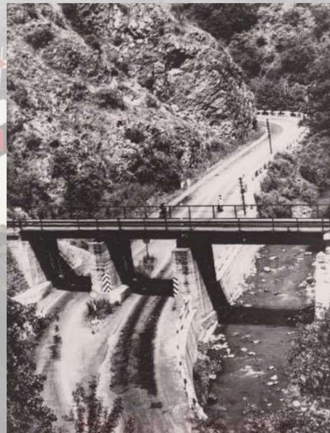
Vasúti völgyhíd Szarvaskő északi végén 1960
