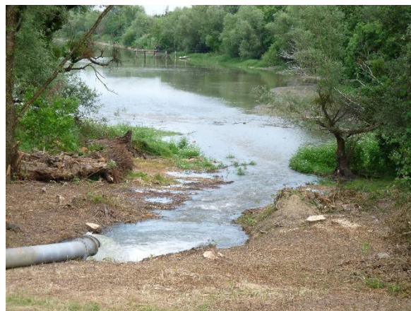
Szivattyúzási hely kiépítése a Bodrognál és az Alsóberecki-Holt-Bodrog vízpótlása
