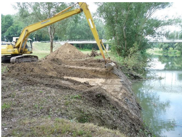
Szivattyúzási hely kiépítése a Bodrognál és az Alsóberecki-Holt-Bodrog vízpótlása
