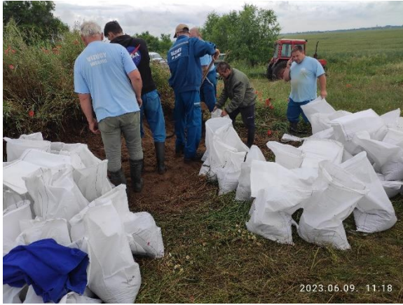
Homokzsák töltés és ideiglenes magasztás az Ágói-patak magasságihiányos szakaszain
