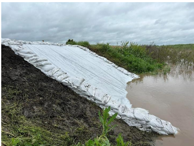
Helyreállítás alatt álló műtárgy ideiglenes bevédése Bene-p bp. 0+605 tkm
