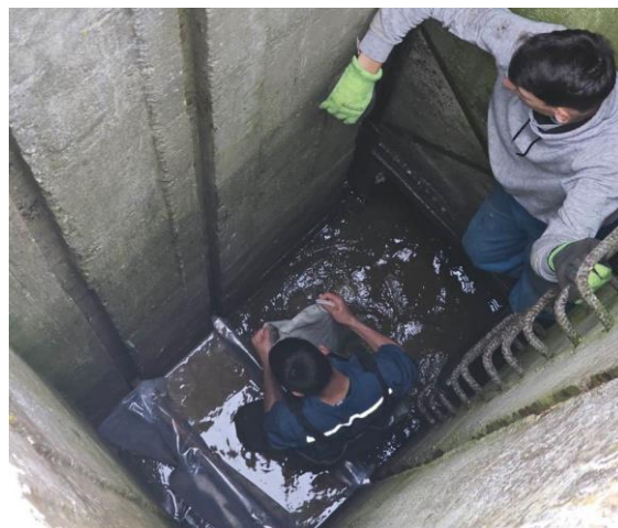
Helyreállítás alatt álló műtárgy ideiglenes elzárás kiépítése Tarna-p bp. 8+878 tkm
